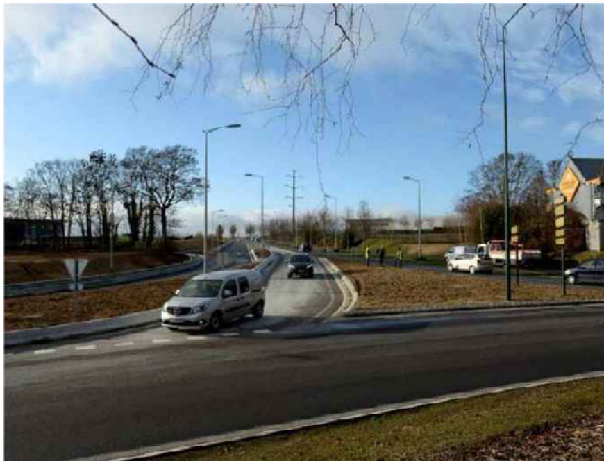
La bretelle de dégagement vers la RD 951 n'est que le début d'autres travaux.
